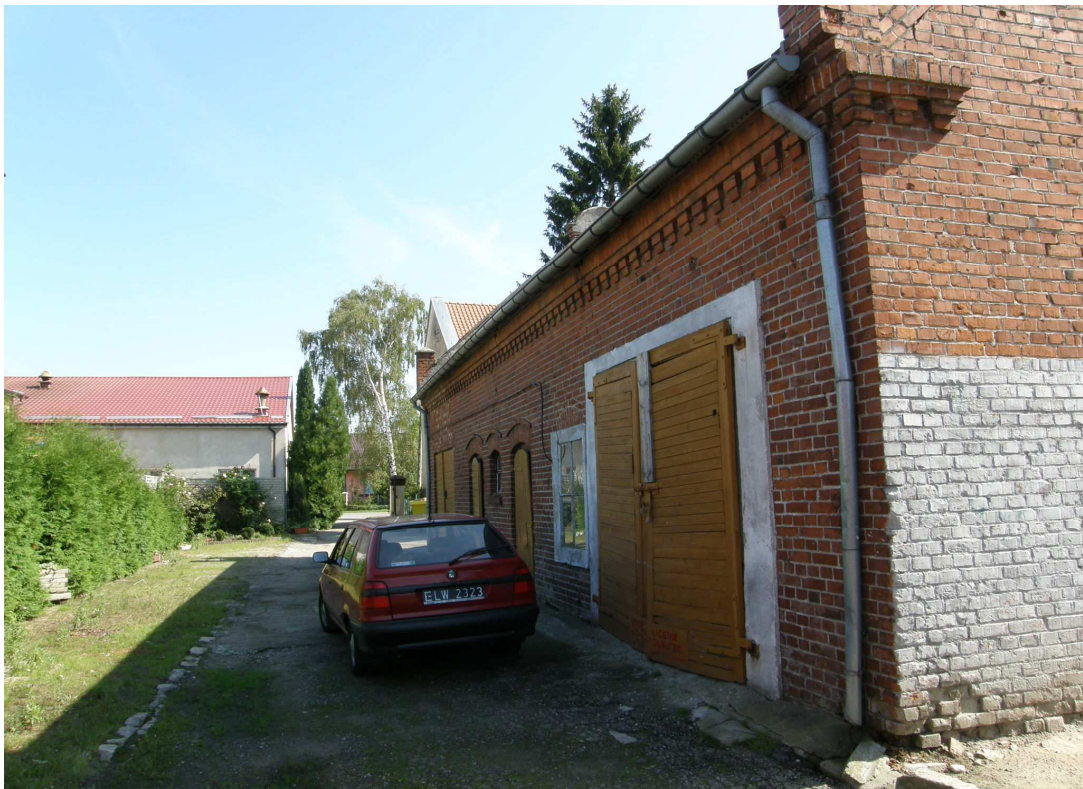
Wykruszone cegły spodniej części muru – elewacja zachodnia.
