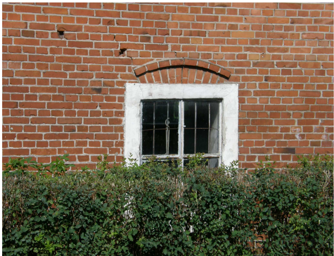
Spękania spoin nad nadprożem ceglanym.
